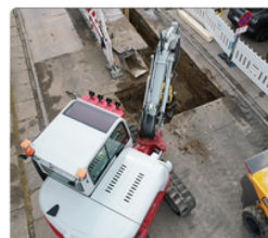
Excavation de fondations
