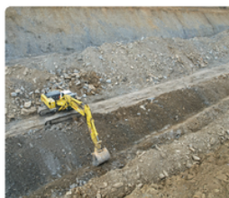
Excavation de tranchées
