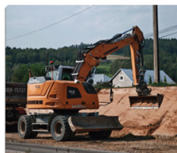
Construction de pentes et de talus
